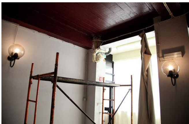
Fig. 7 – Reparação de infiltração na sala de sócios
