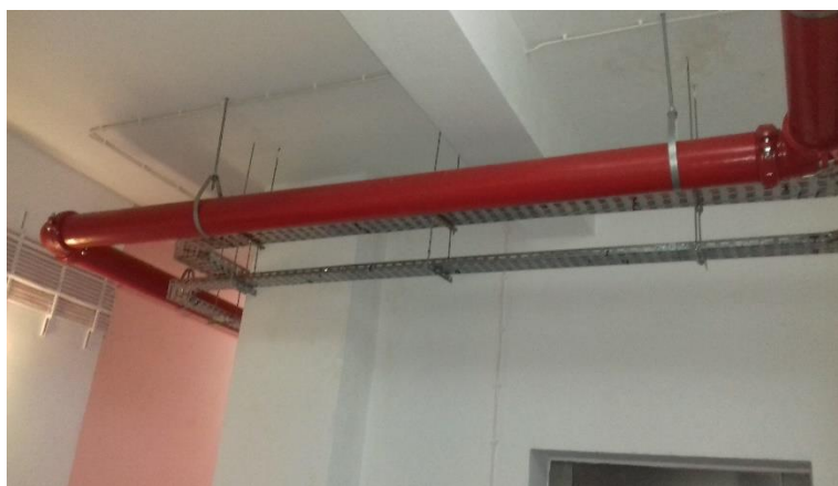
Fig. 12 – Novas tubagens da Rede de Incêndio Armada (RIA)
