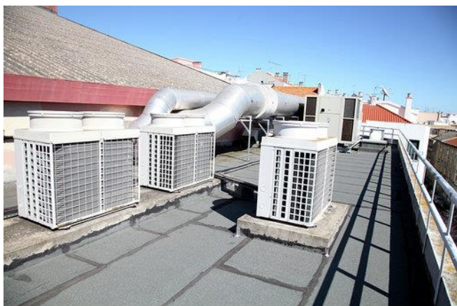
Fig. 5 – Bomba de calor reparada
