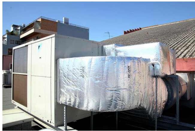
Fig. 6 – Novo equipamento de ar condicionado
