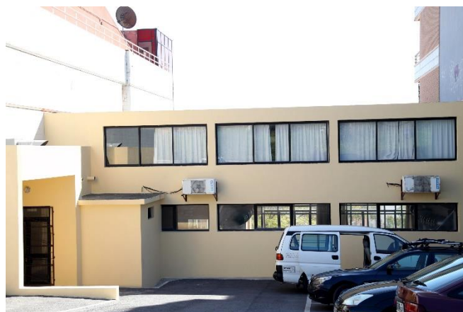
Fig. 2 – Reparação do alçado tardoz
