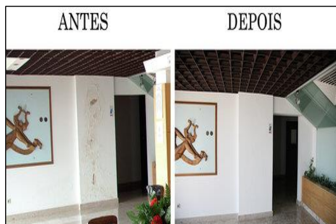
Fig. 8 – Reparação de infiltração no foyer do auditório
